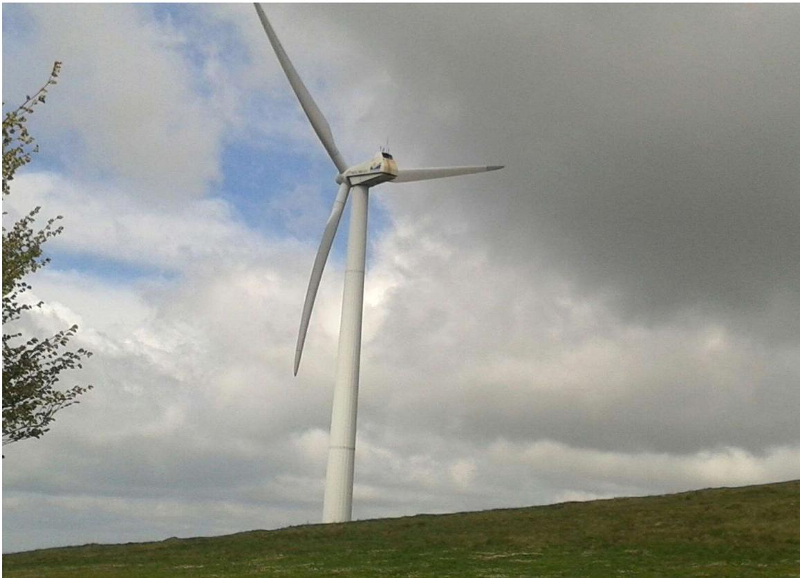
Le considérable vent de Cima Mutali ( 9 m / s moyen annuel) permet une production annuelle moyenne de 3,339,691 kWh par an. La puissance et la production annuelle couvre les besoins en électricité de 1335 familles.
